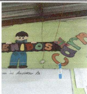
FOTO 7: Instalación de unidades luz (incluye interruptor, ducto y cable eléctrico)
