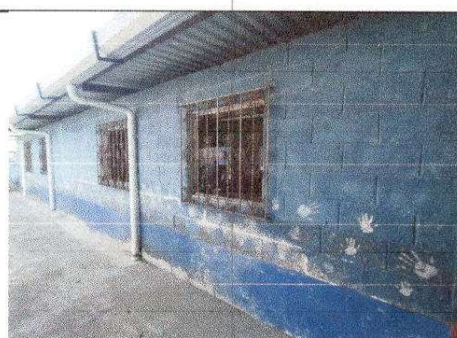
FOTO 10: Repello en muro
