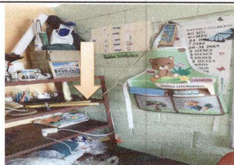
FOTO 8: Instalación de unidades fuerza (tomacorriente), incluye cable eléctrico
