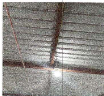
FOTO 6: Instalación de unidades luz (incluye interruptor, ducto y cable eléctrico)
