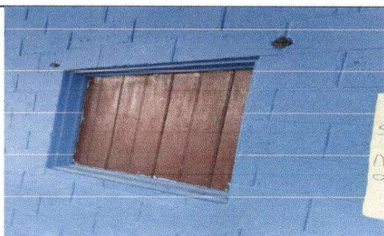
FOTO 9: Fabricación e instalación de ventana-balcon de metal
