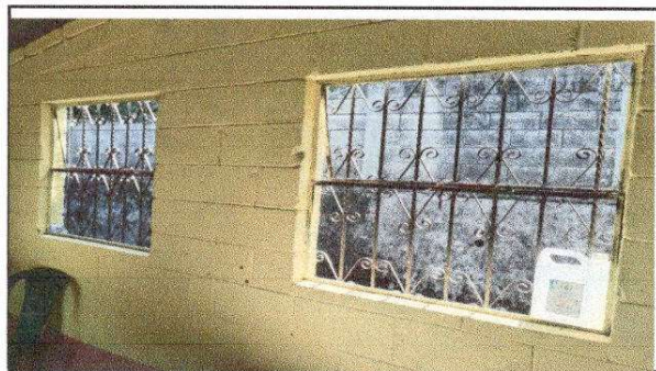
FOTO 5: Fabricación e instalación de balcones de hierro en ventana
