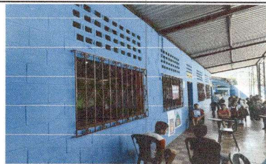
FOTO 4: Pintura en muros exteriores e interiores
